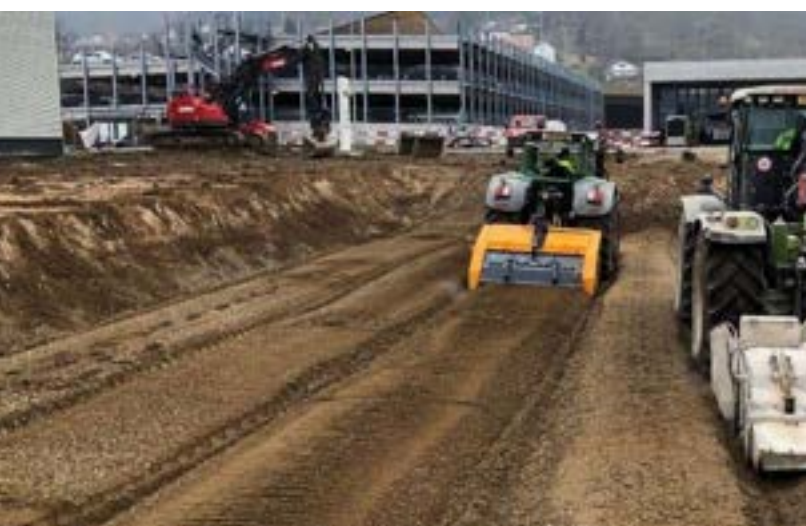
Verwendung des eigenen Aushubes für die Herstellung
